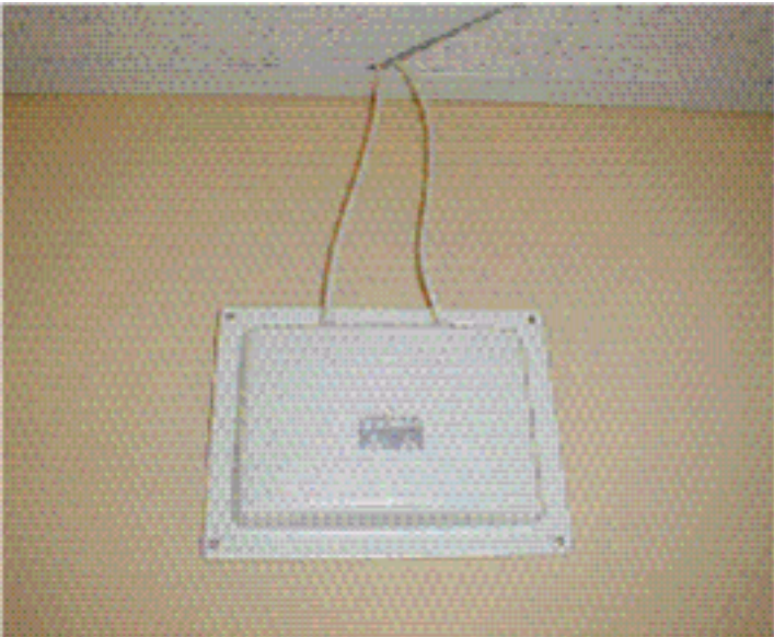
그림 24 — 벽에 장착된 Cisco Aironet 2012 안테나
