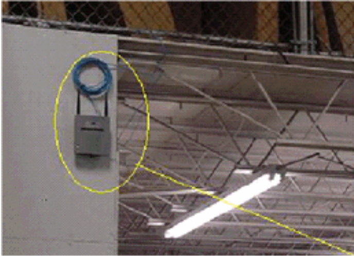
그림 19 — I형으로부터 떨어진 벽면에 장착된 액세스 포인트 및 안테나
