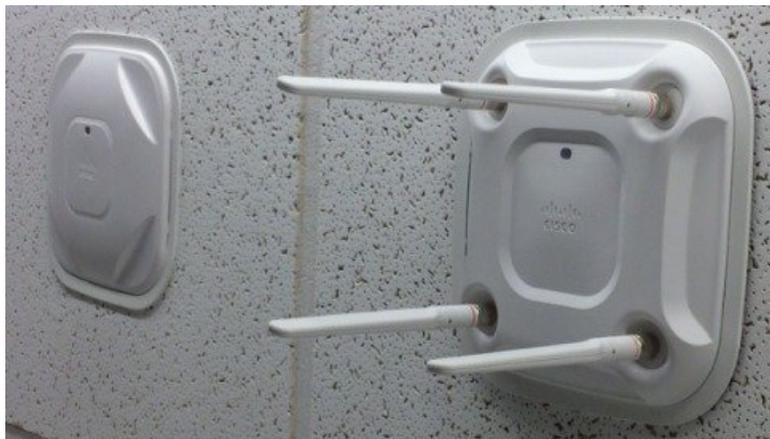
AIR-BRACKET-3 は Hyperlocation アンテナ AIR-ANT-LOC-01= には使用できません。これは Hyperlocation アンテナアレイの機構、および正確なアジマス位置が必要とされることが原因です。
